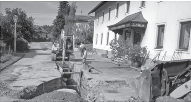
Schmutzwasserkanals in der Griesbacherstraße begonnen. Mit diesem Bauabschnitt werden die umfangreichen Kanalbauarbeiten für heuer beendet. Um Setzungen im Bereich der Kanalkünetten zu verhindern, werden die Asphaltierungen der betroffenen
